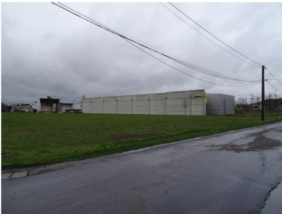
Vue depuis le chemin d'exploitation au Sud du site de projet, angle Sud-Est
