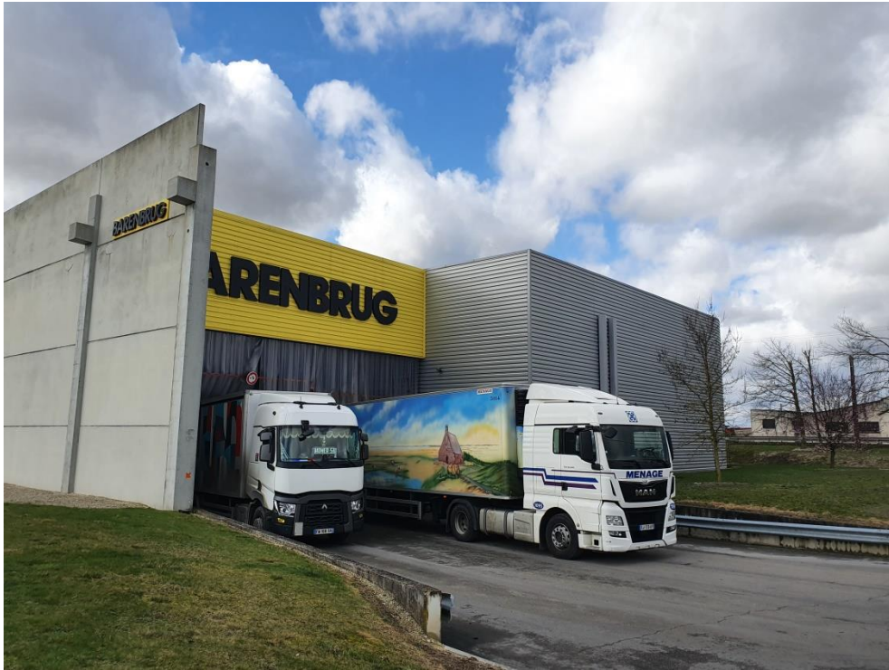
Illustration n° 8 : Quai de chargement du site
