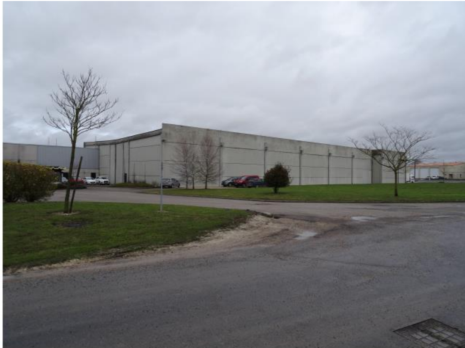
Vue depuis le chemin d'exploitation au Sud du site de projet, angle Sud-Ouest
